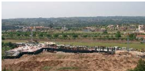
Vista de las obras del Vilar Rural d'Ares (Terra Alta)
