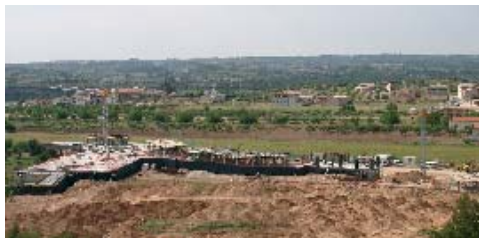
Vista de les obres del Vilar Rural d'Arnes (Terra Alta)
