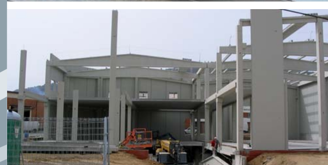
Construcció de la nova nau de Creasa, S.L. (Pineda de Mar).
