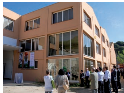
La nueva nave de SERHS Food Service en Arenys de Munt tiene 4.500 m 2 construidos con la posibilidad de ampliar esta superficie hasta casi 6.000 m 2 .
